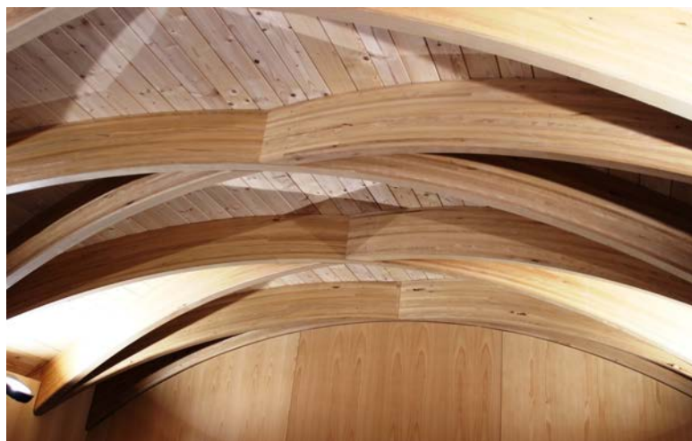
Charpente en mix hêtre (structure) – épicea (parement) de la structure d'accueil des habitations de loisir, à Xertigny (Photo de Quentin REMY)
